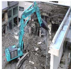
旧奈良県総合医療センター(除却)
